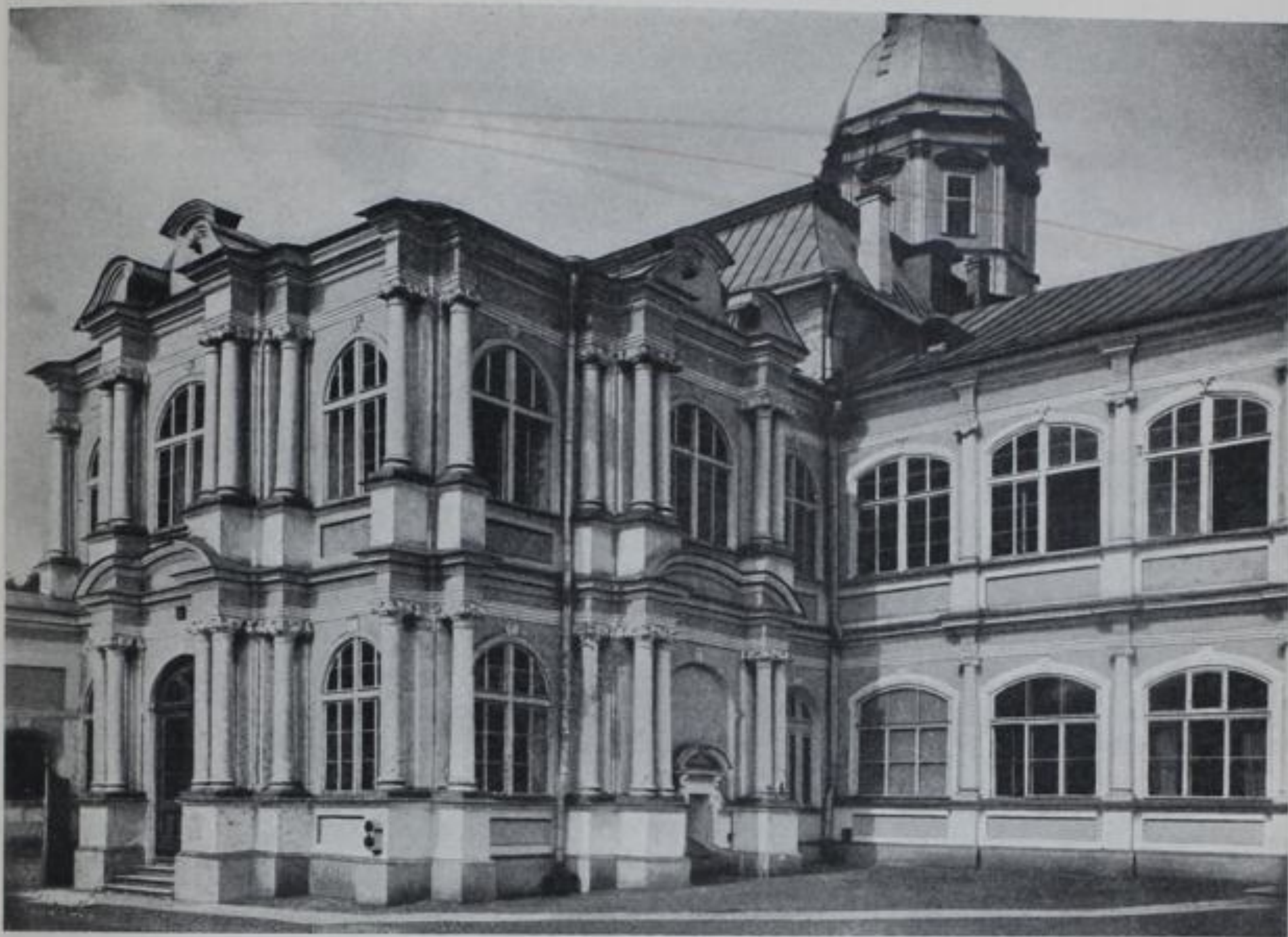
Лѣстничная пристройка Александрo-Благовѣщенской церкви Александрo-Невской лавры.—1764 г.
