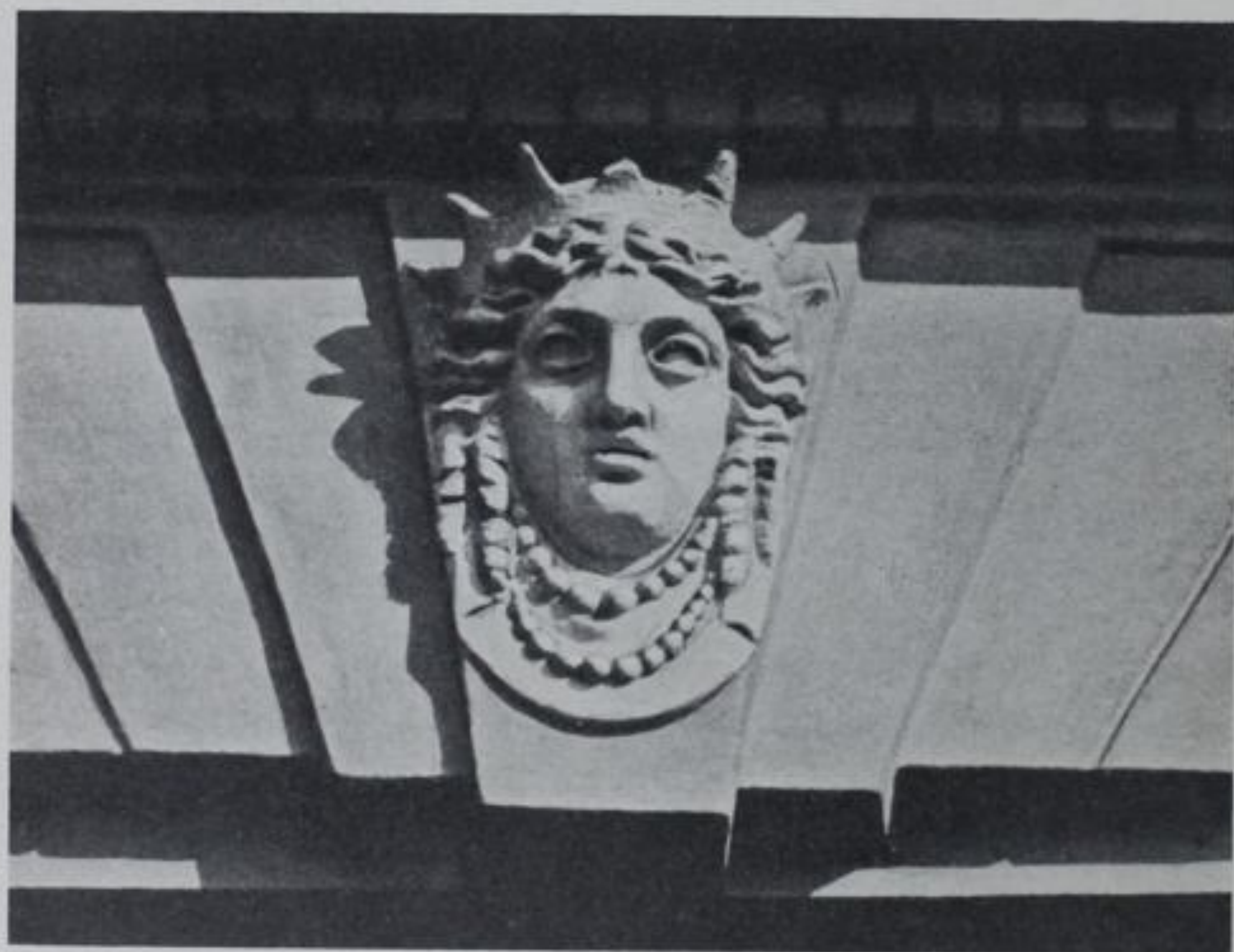
Захаровъ. Детали Адмиралтейства,—колоннада башни и маска оконного замка. 1806—1815 г.
